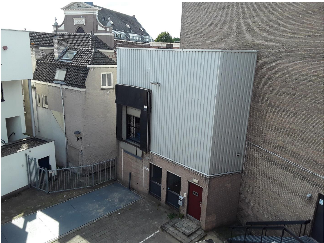
Loading dock De Nieuwe Doelen (bron: PBTA)
